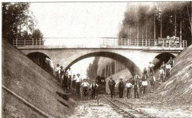
Gleisbauarbeiten an der Brücke vor Winkling im Jahr 1913. Foto: Johann Diel
